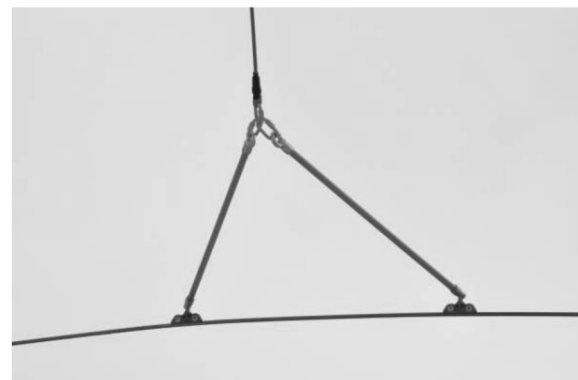
Рис. 5. Элемент крепления контактной сети, Хасановская улица, Санкт-Петербург
