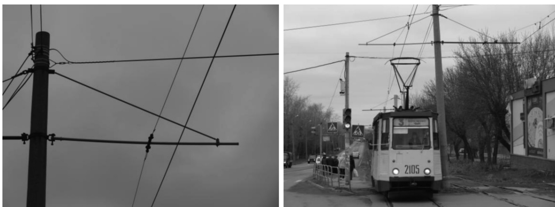
Рис. 7. Трамвайная консоль на улице Жукова, Челябинск
